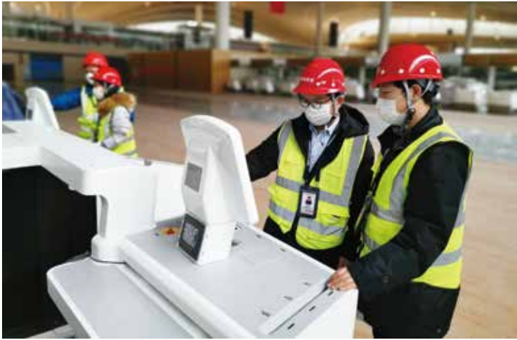
青岛凯亚员工在青岛新机场项目现场调试设备
